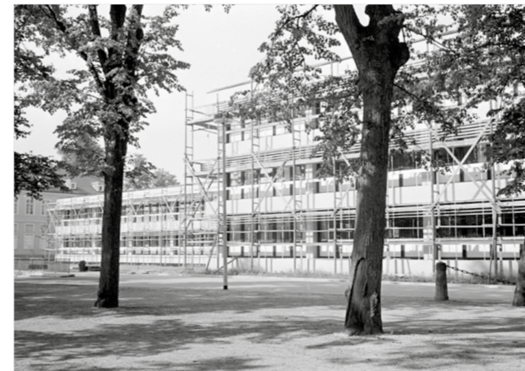
Bauarbeiten am Baumgarten-Bau
